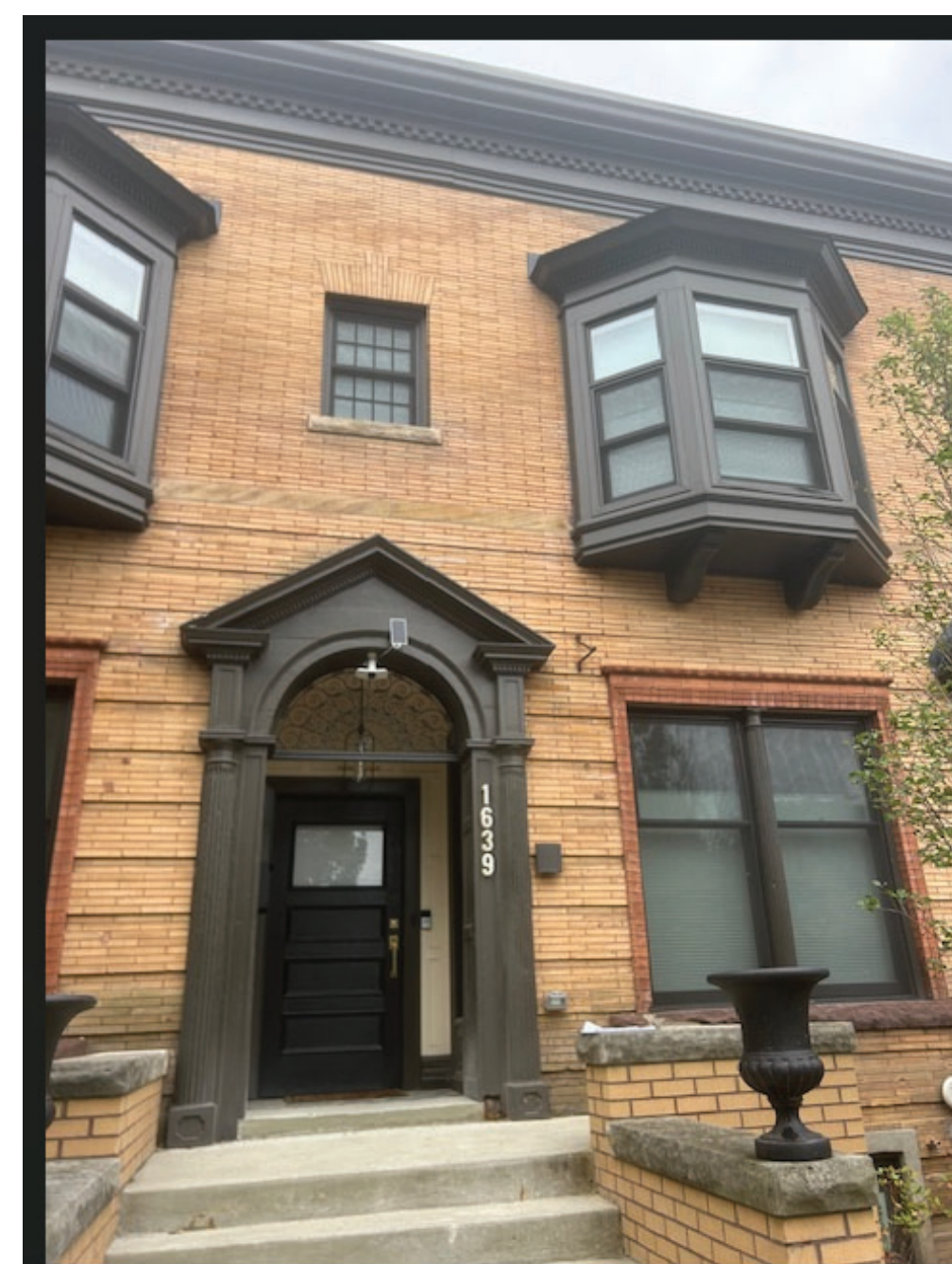
EXISTING EXTERIOR PHOTOS SCALE: NONE
