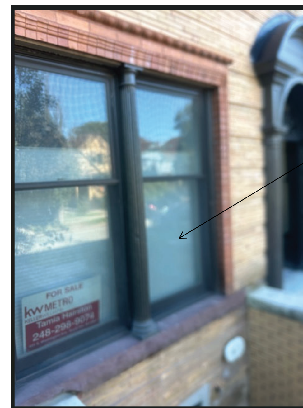
EXISTING EXTERIOR PHOTOS SCALE: NONE
