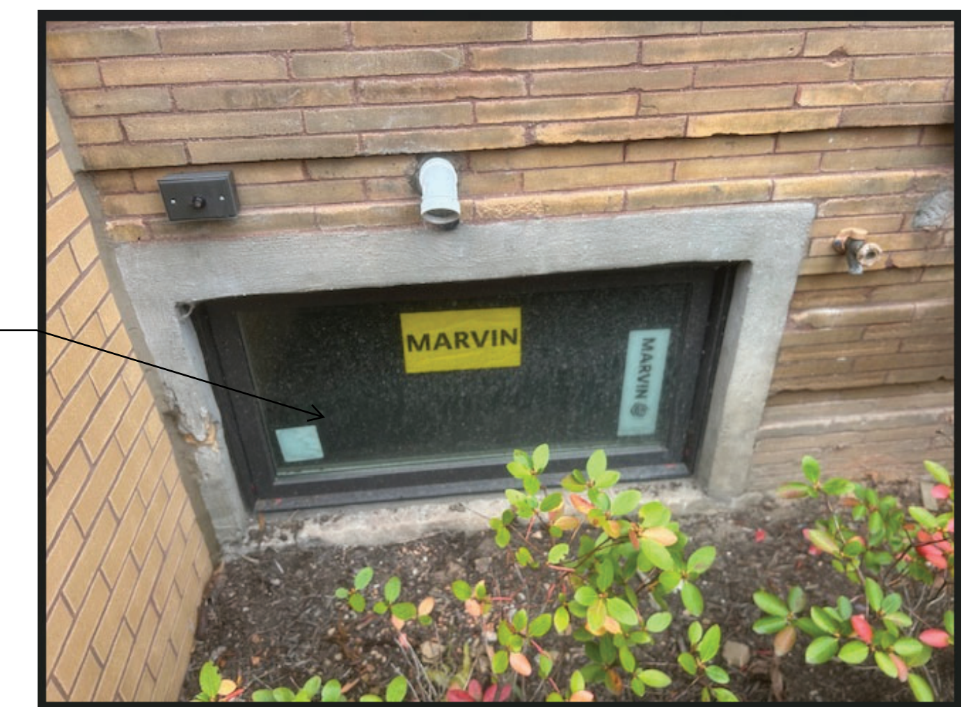
EXISTING EXTERIOR PHOTOS SCALE: NONE
