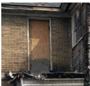
Back Upper Porch Door
